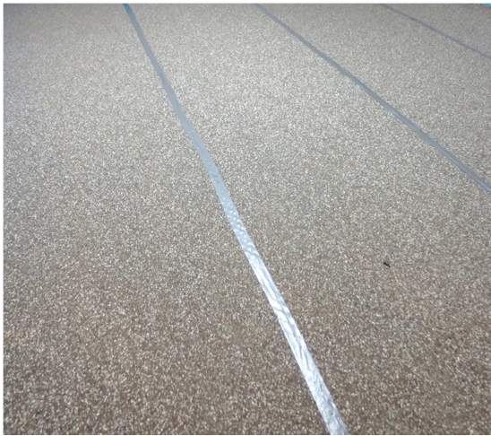
Abbildung A 2.2: Montagesituation a) Verlegung der Trittschalldämmmatten auf der erhärteten Ausgleichs- und Schalldämmschüttung, Stöße mit Klebeband, b) nach Auflegen der RenoScreed SarkingMembrane Bahn
