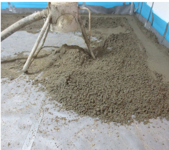
Abbildung A 2.3: Montagesituation Zementestrich
