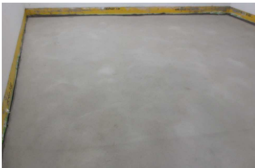
Abbildung A 2.3: Zementestrich (Prüfsituation)
