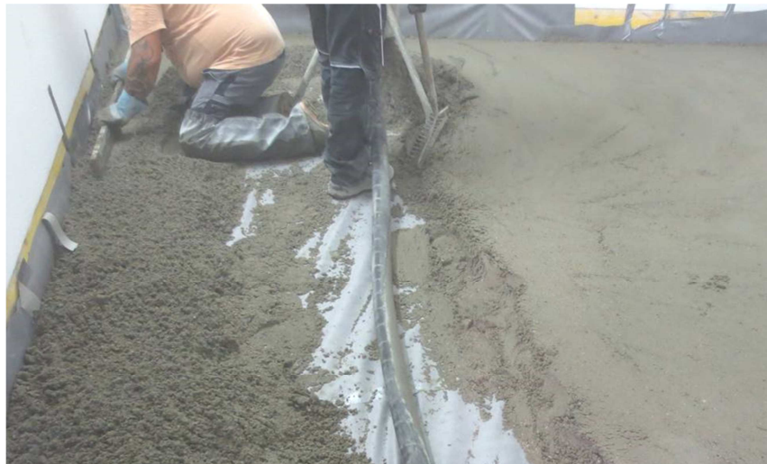
Abbildung A 2.2: Montagesituation mit Zementestrich
