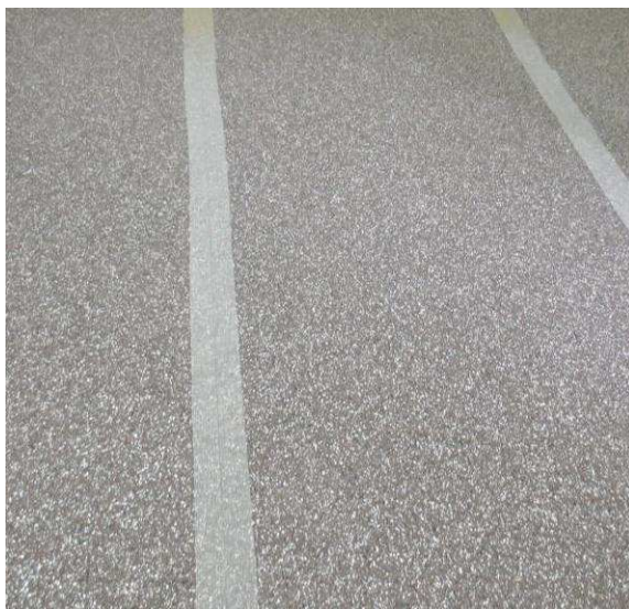
Abbildung A 4.2: Montagesituation a) Verlegung der Trittschalldämmmatten auf der erhärteten Ausgleichsschüttung, Stöße mit Klebeband, b) nach Auflegen der RenoScreed SarkingMembrane Bahn
