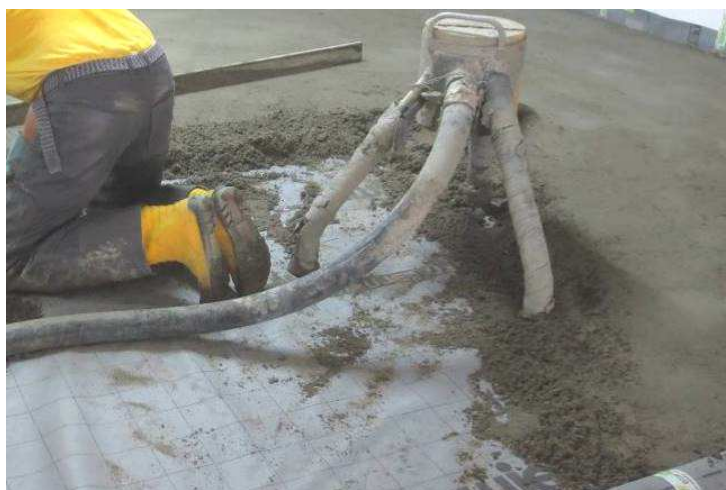
Abbildung A 4.3: Montagesituation mit Zementestrich
