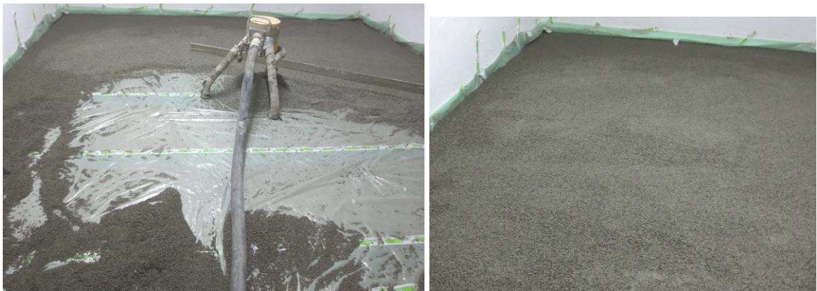
Abbildung A 4.1: Montagesituation – Einbau der Ausgleichsschüttung
