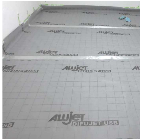
Abbildung A 4.2: Montagesituation a) Verlegung der Trittschalldämmmatten auf der erhärteten Ausgleichsschüttung, Stöße mit Klebeband, b) nach Auflegen der RenoScreed SarkingMembrane Bahn
