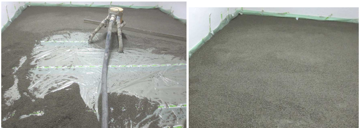
Abbildung A 4.1: Montagesituation – Einbau der Ausgleichsschüttung
