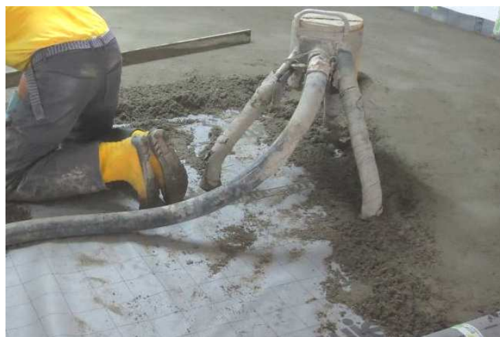
Abbildung A 4.3: Montagesituation mit Zementestrich
