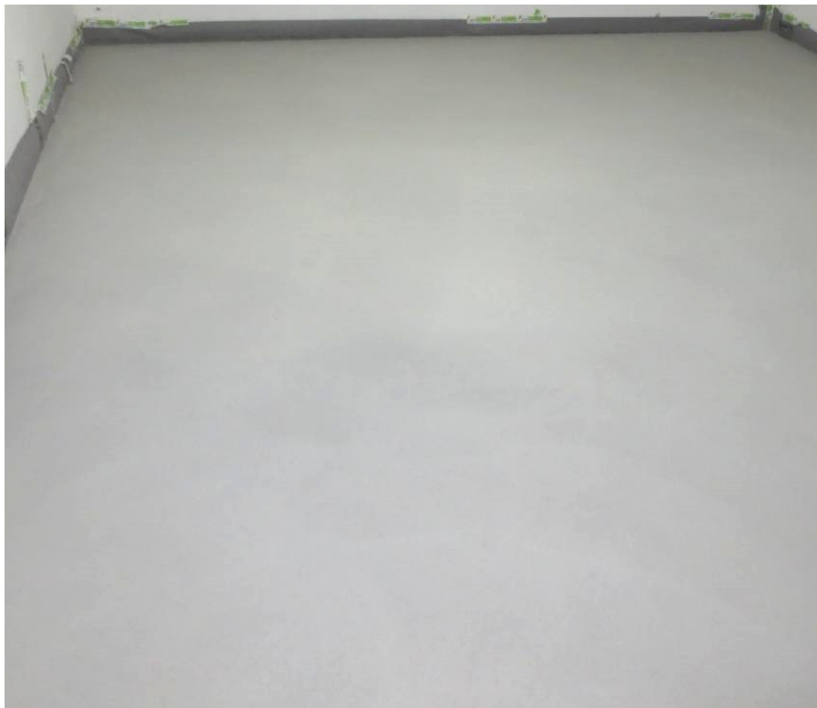
Abbildung A 4.4: Zementestrich (Prüfsituation)
