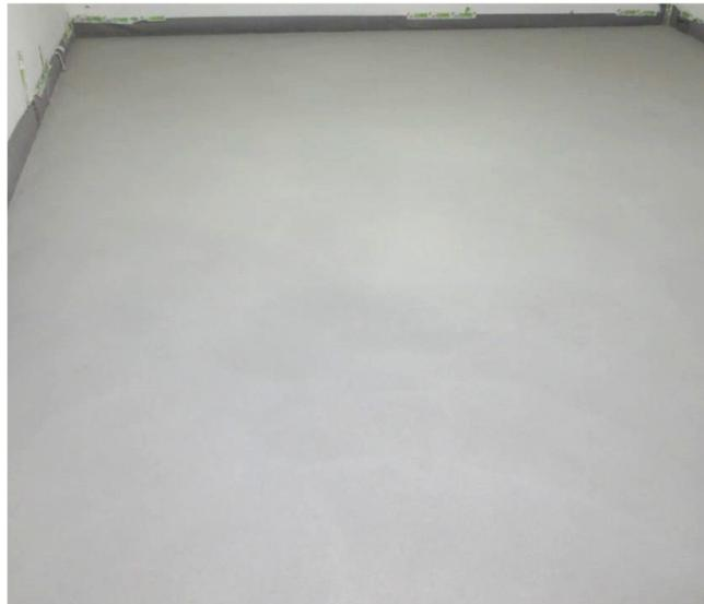
**Abbildung A 2.5:** Zementestrich (Prüfsituation)
