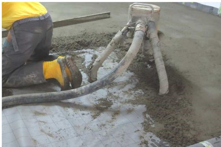
**Abbildung A 2.3:** Montagesituation mit Zementestrich
