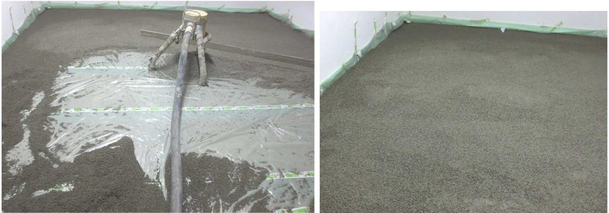
**Abbildung A 2.1:** Montagesituation – Einbau der Ausgleichsschüttung
