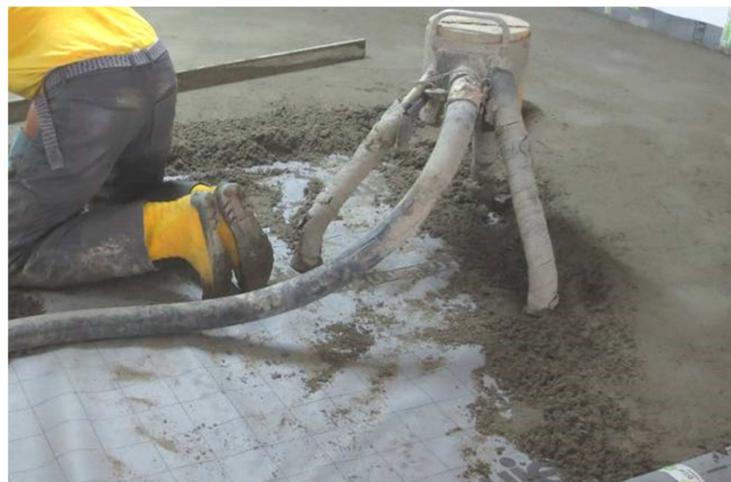
**Abbildung A 2.3:** Montagesituation mit Zementestrich
