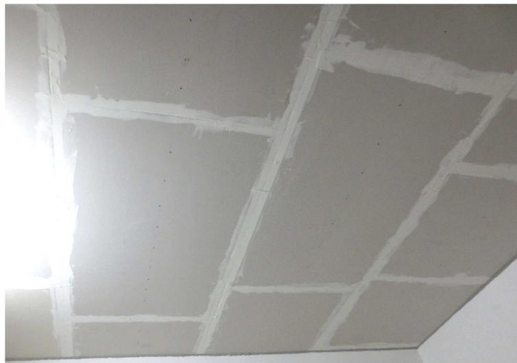
**Abbildung A 2.6:** Unterdecke (Prüfsituation)
