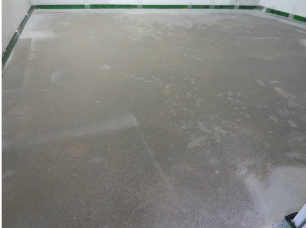
Abbildung A 2.3: fertiggestellter Zementestrich (Prüfsituation)
