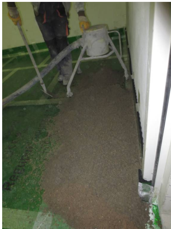
Abbildung A 2.2: Montagesituation mit Zementestrich
