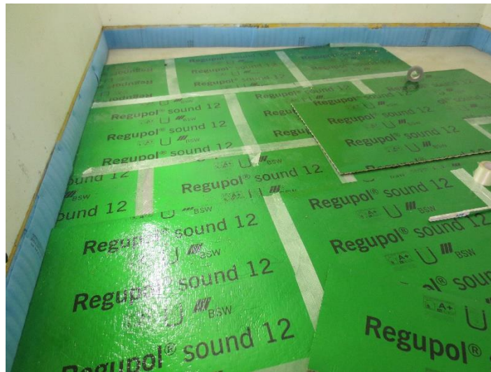
Abbildung A 2.1: Montagesituation mit Trittschalldämmmatten (2-lagig) und Randdämmstreifen, Stöße mit Klebeband
