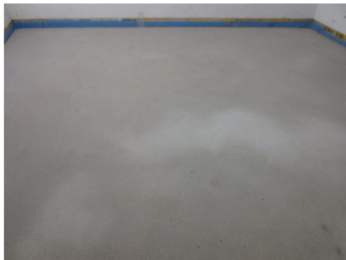
Abbildung A 2.3: Zementestrich (Prüfsituation)
