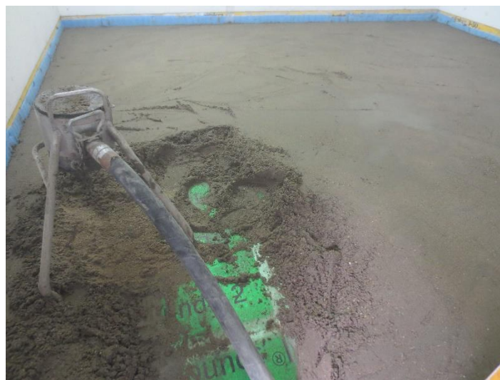
Abbildung A 2.2: Montagesituation mit Zementestrich
