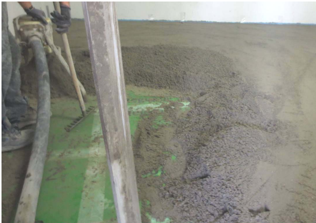
Abbildung A 2.2: Montagesituation mit Zementestrich
