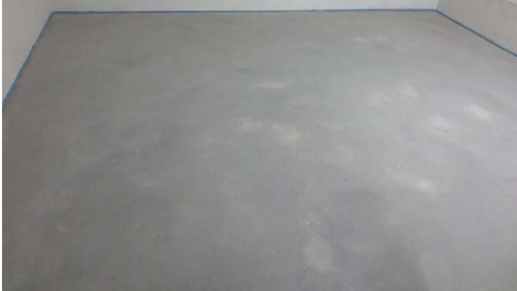
Abbildung A 2.3: Zementestrich (Prüfsituation)
